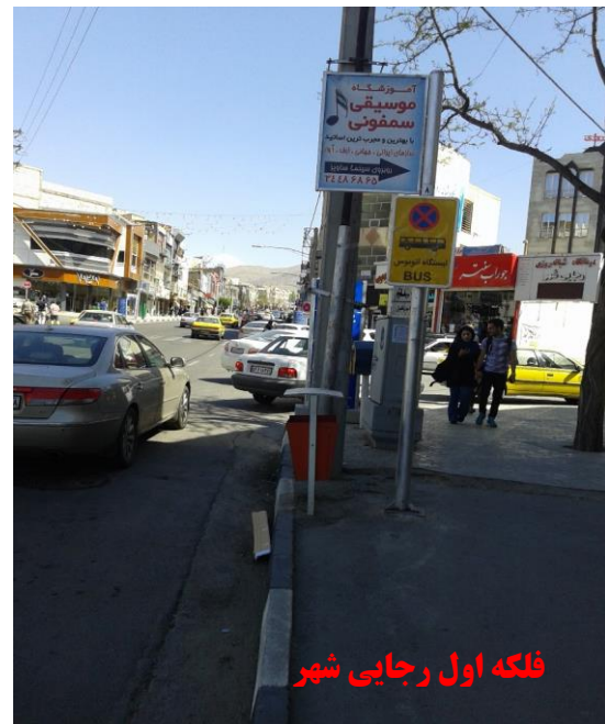
شکل ۷: عدم وجود پهلوگاه و کف نویس در ایستگاه‌های اتوبوس شهر کرج
